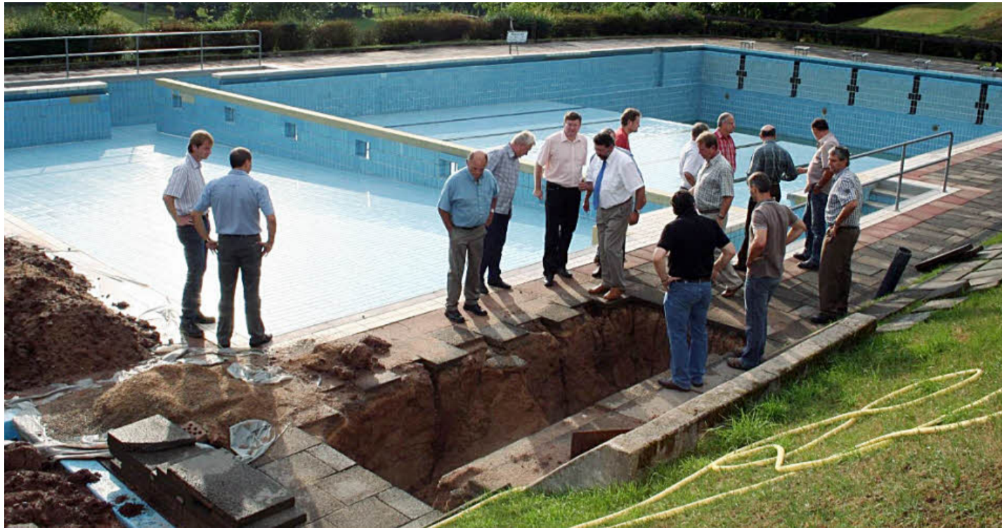
2008 war das Freibad in Aschbach schon einmal Baustelle. Doch die damalige Sanierung reichte nicht aus. Jetzt muss die Stadt Schlüsselfeld nach einem Bürgerentscheid zum Erhalt des Bades nachbessern.
