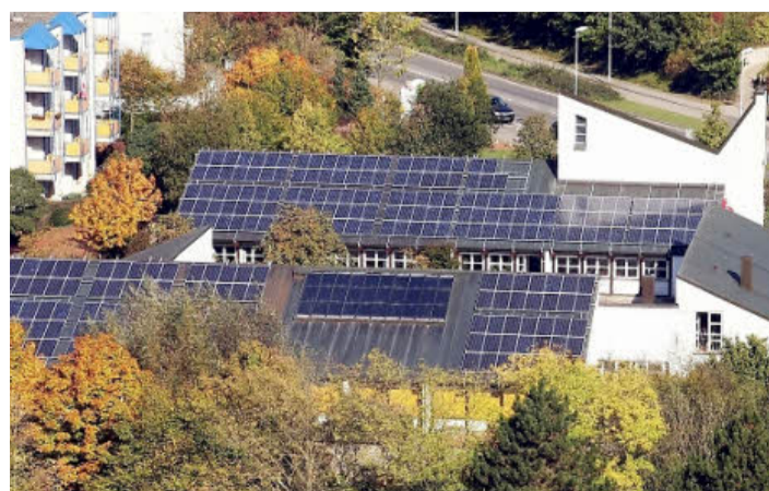
Blick auf die Sonnenkollektoren auf dem Gemeindezentrum der Philipuskirche in Bamberg. Foto: Rieger/Press
