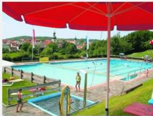
Die Idylle trügt: Das Aschbacher Freibad ist stark renovierungsbedürftig. Die Kosten allerdings gehen in die Millionen.
